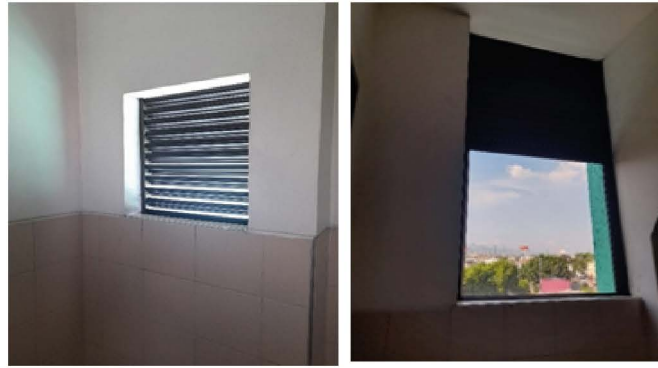
Registro fotográfico: cambio de ventanas en aluminio
