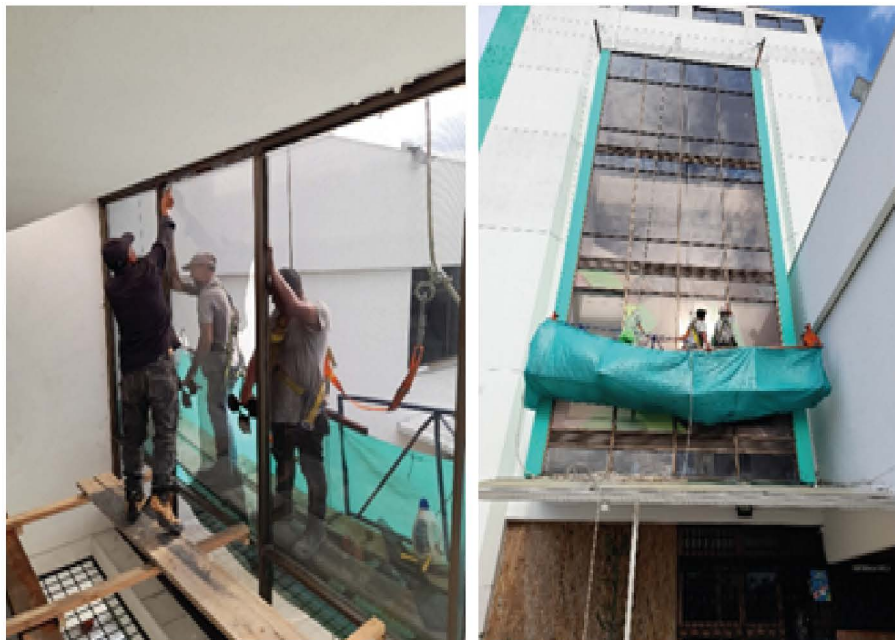
Registro fotográfico: trabajos realizados en el ventanal panorámico.
