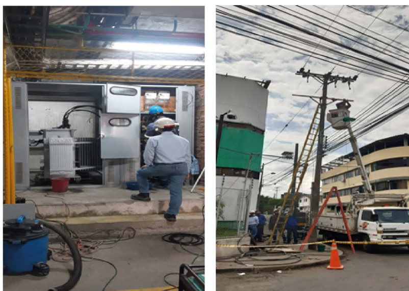
Registro fotográfico: cambio de porta circuitos y protecciones DPS (Red monopolar)
